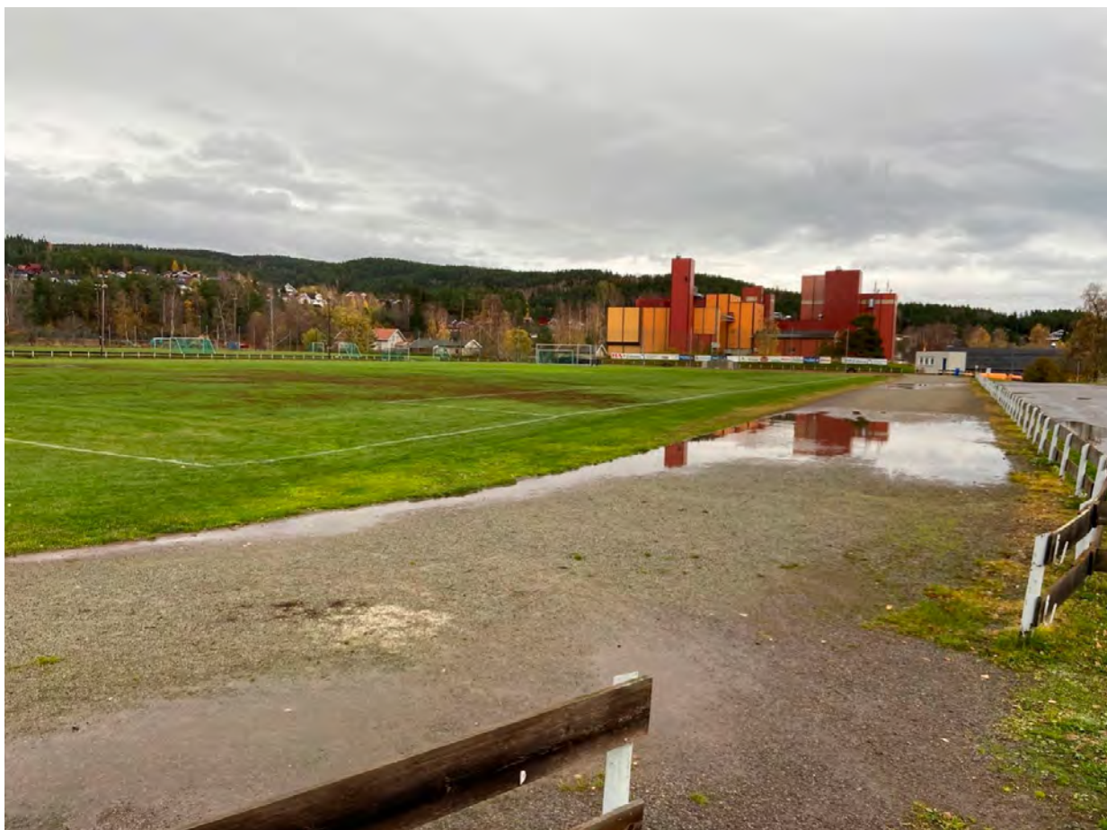
SKAL FÅ ET LØFT: Idrettsparken i Moelv får et løft og skal bli et moderne friidretts- og fotballanlegg.
